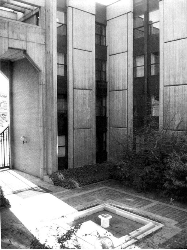
Görsel 29. 1978, TBMM Halkla İlişkiler Binası, Behruz Çinici - Mimarlar Odası Ulusal Mimarlık Ödülleri Mimar Sinan Büyük Ödülü (2004). > YIKILDI
