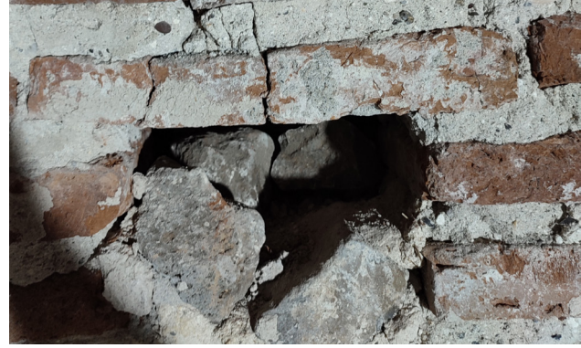
Şekil 3.7 : Melik Ahmet Paşa Cami kubbesinde zemin oturmasına bağlı gelişen çatlama ve kırılma hasarları (Hakseven, 2024).
