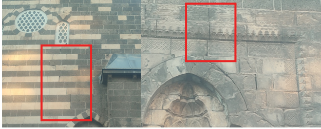
Şekil 3.8 : Melik Ahmet Paşa Cami kubbesinde ve taç kapının doğu ayağında meydana gelen kırılma hasarları (Düzenleyen: Hakseven, 2024).
