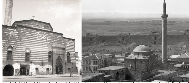
Şekil 2.2 : Diyarbakır Melik Ahmet Paşa Cami'nin genel görünümü (VBM Arşivi).
