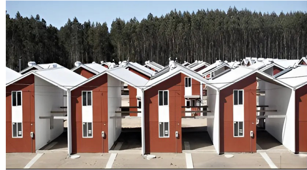
Şekil 8: Villa Verde (Constitucion/Şili) A. Aravena – 2013 (deprem sonrası: yarım evler) (Fotograf: Chia, Martinez 2024)
