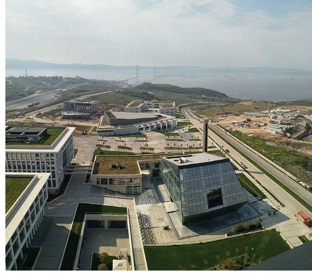
Görsel 3: Bilişim Vadisi İdari Kuleden görünüm, (Nisan 2019, Cem Korkmaz).
