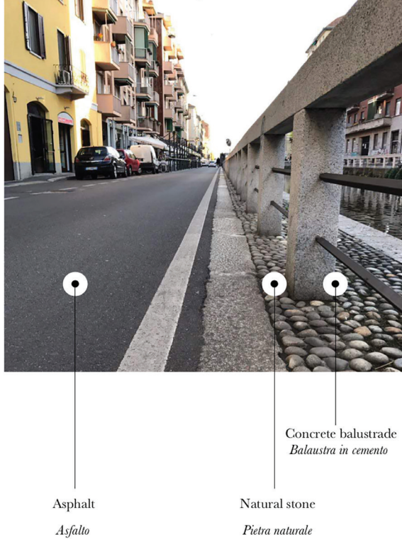
Existing materials and condition of Naviglio Pavese Materiali corrente e la condizione di Naviglio Pavese
